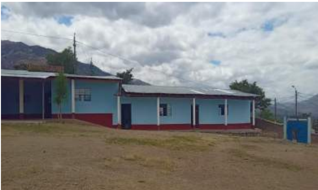
Fotografía del puesto de salud de la comunidad de Aycas
