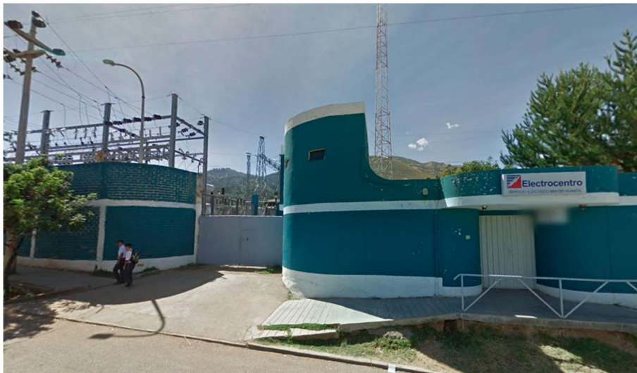
Figura N° 12. Centro de atención de Electrocentro del distrito y provincia de Huanta.
