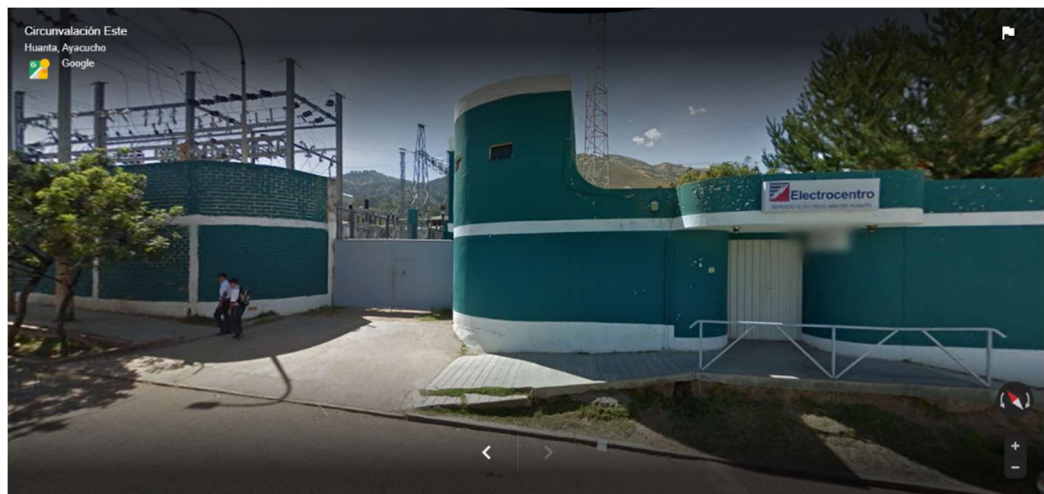
Figura 10. Vista frontal de la Institución de Electrocentro en Huanta
