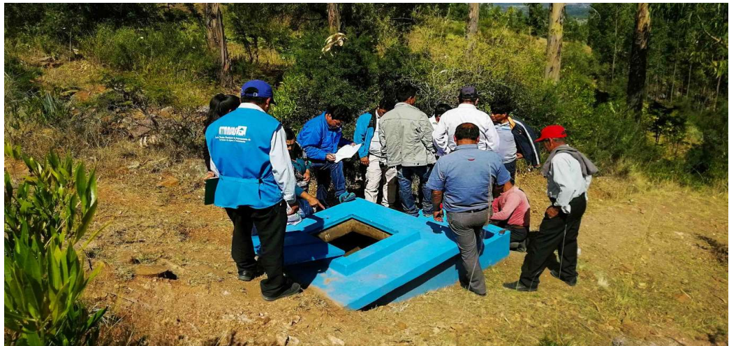
Figura 9. Inspección del reservorio en comunidad de Huancayoccc
