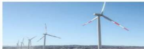
Planta de energía eólica, Wayra I
